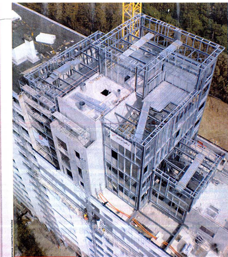
Pour la structure métallique, Poralu privilégie une conception au moyen de cadres en Upaf (profilé à froid prégalvanisé) afin de minimiser le poids des façades complétées par des planchers collaborants. L'isolation intégrée entre les fers diminue les ponts thermiques et améliore la performance acoustique. Un bardage imitation pierre (Ardal de chez Carea) et une tôle 10/10" (avec deux plaques de plâtre) assurent la finition respective, extérieure et intérieure.
