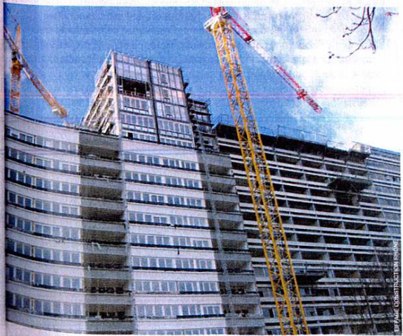
Pour la structure métallique, Poralu privilégie une conception au moyen de cadres en Upaf (profilé à froid prégalvanisé) afin de minimiser le poids des façades complétées par des planchers collaborants. L'isolation intégrée entre les fers diminue les ponts thermiques et améliore la performance acoustique. Un bardage imitation pierre (Ardal de chez Carea) et une tôle 10/10" (avec deux plaques de plâtre) assurent la finition respective, extérieure et intérieure.
